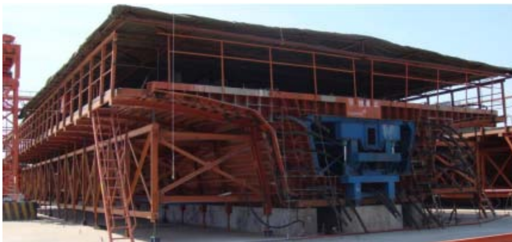
图 4.13 预制箱梁模板
