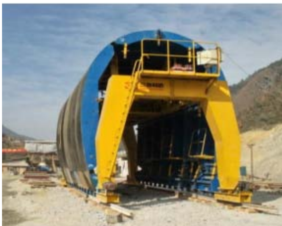
图 4.15 隧道模板台车
