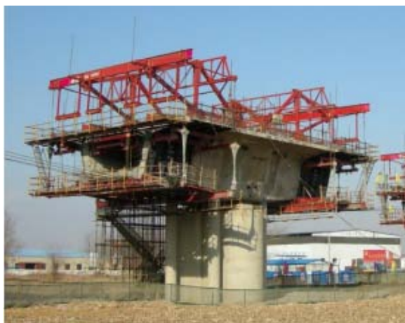
图 4.14 挂篮悬臂施工
