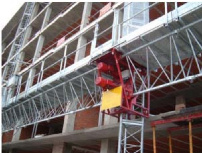
图 4.12 电动桥式脚手架
