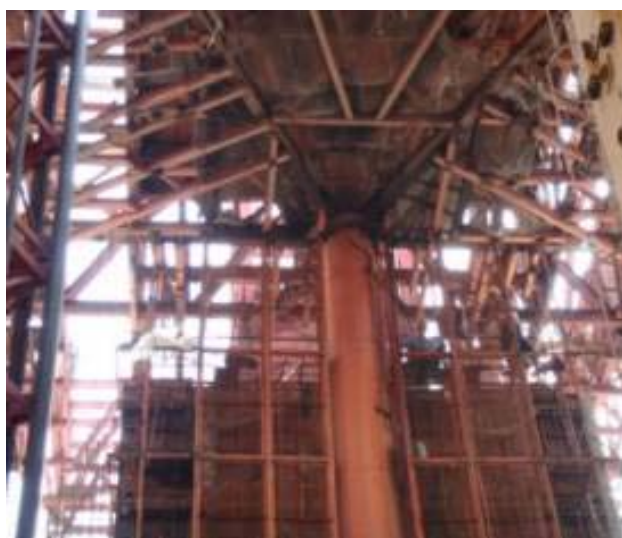
图 4.7 大吨位长行程油缸顶升模板
